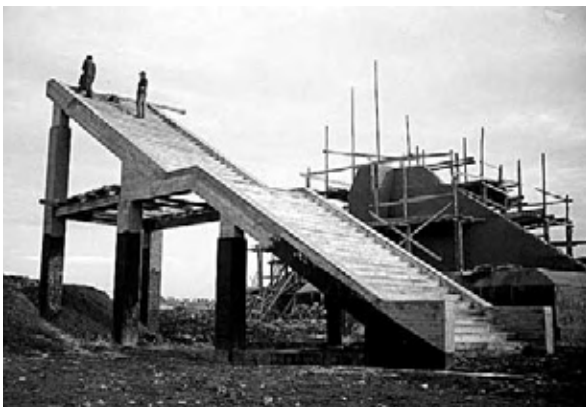
Baustelle Frankfurter Wiesen Construction site, Frankfurt
